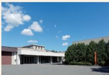
本社工場外観
